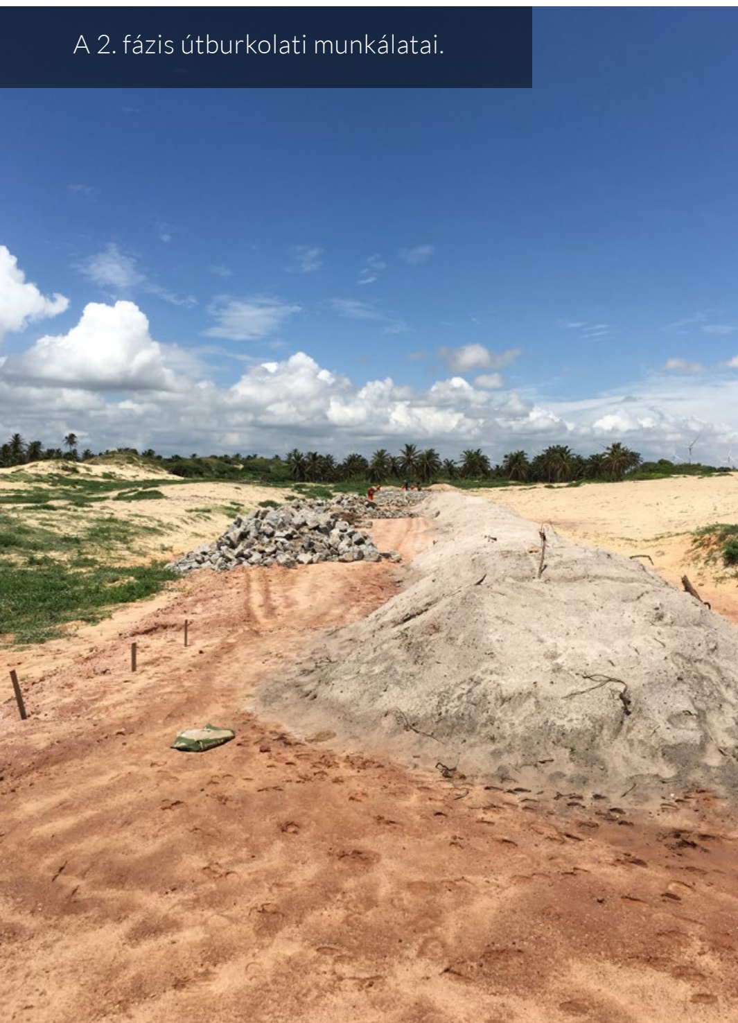
A 2. fázis útburkolati munkálatai.
