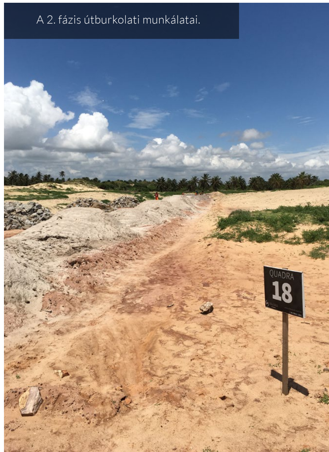
A 2. fázis útburkolati munkálatai.
